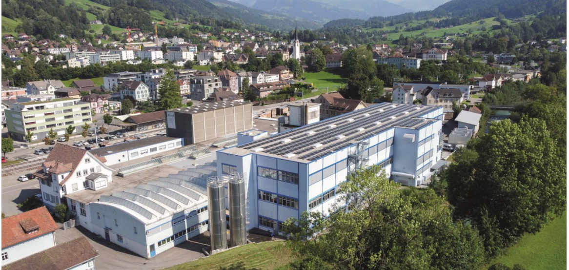
Rückansicht des Produktionsgebäudes mit Blick auf die Photovoltaik-Anlage
